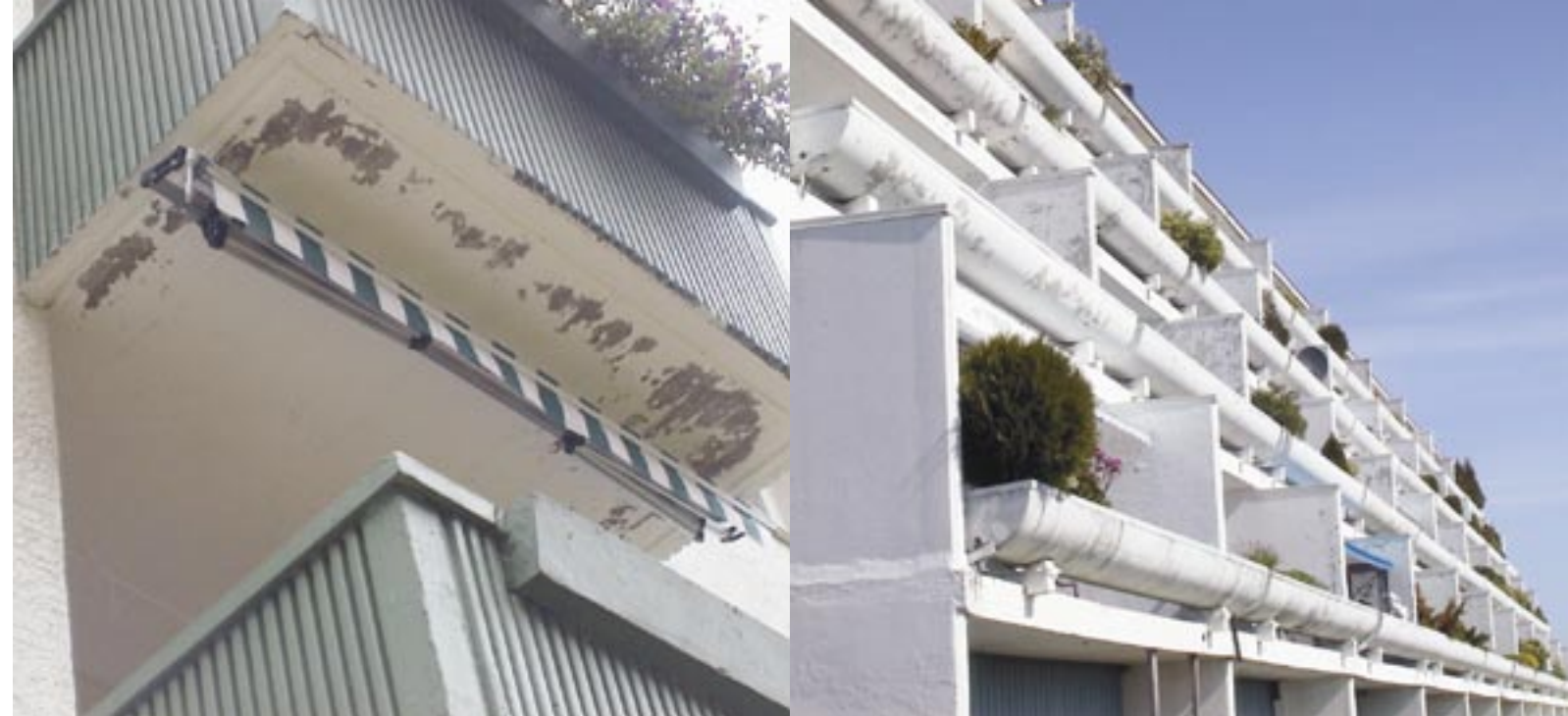
Exempel på avflagningsarbete
