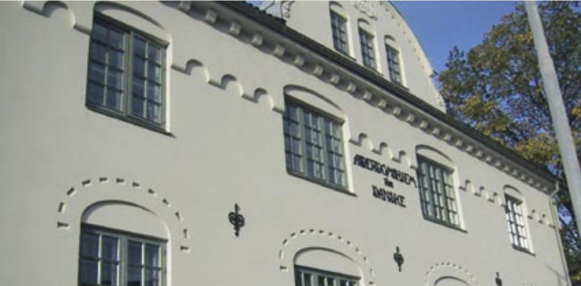
Testprosjekt 2004: Frithjof Nansens vei 22, Oslo. Produktsystem: Jotun Mur Silikonemulsion. Malermester: Olav Ottersen A/S.
