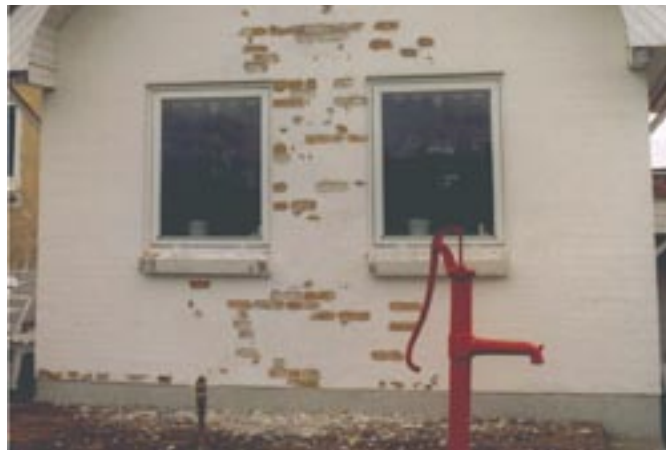
Bilderna visar en tegelfasad som påförts ett allt för tunt lager puts och sen målats. Omfattande problem med frostsprängningar har blivit följden
